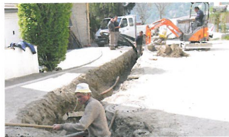
Verlegung der Leer-Rohre in Schlanders
